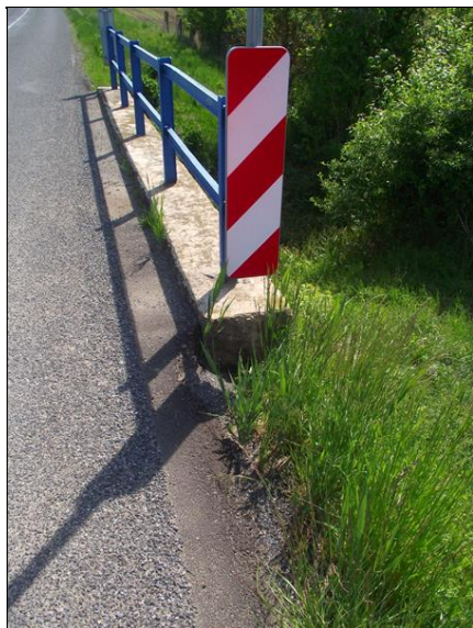
Detail levé římsy u opěry OP2 - nenávaznost terénu na římsu.
