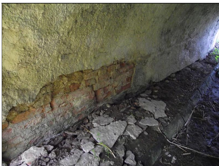
Detail rozpadu spodní části klenby u opěry OP2.
