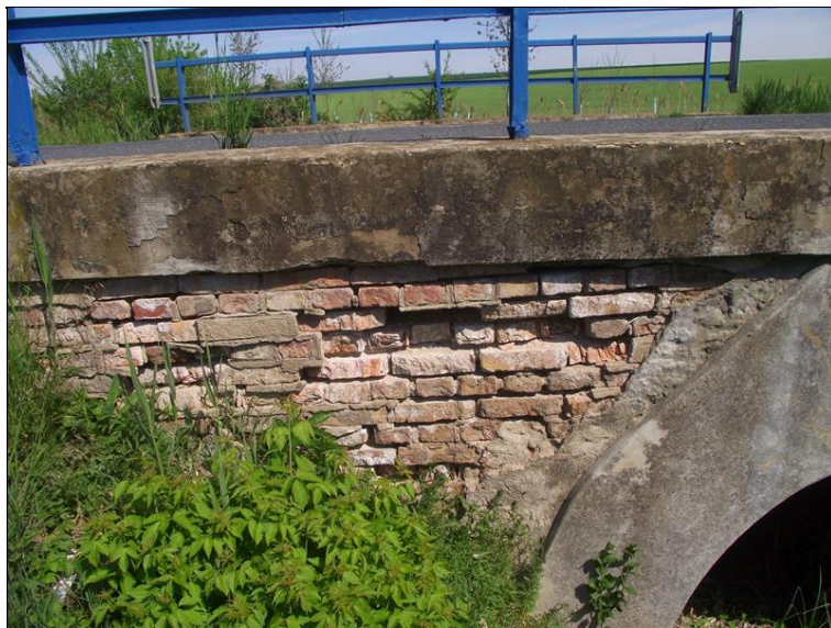
Levé křídlo u opěry OP2. Detail rozpadu cihelného zdiva.
